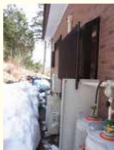
⑥ガス給湯器の配置 (3月18日)
