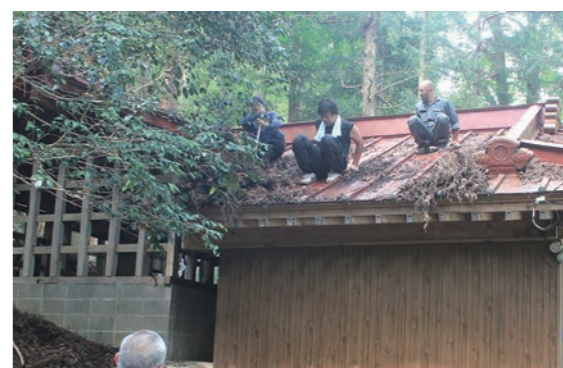
③お堂の屋根に堆積した杉葉を掃除
