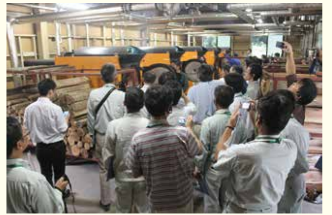
薪ボイラーの視察見学風景
