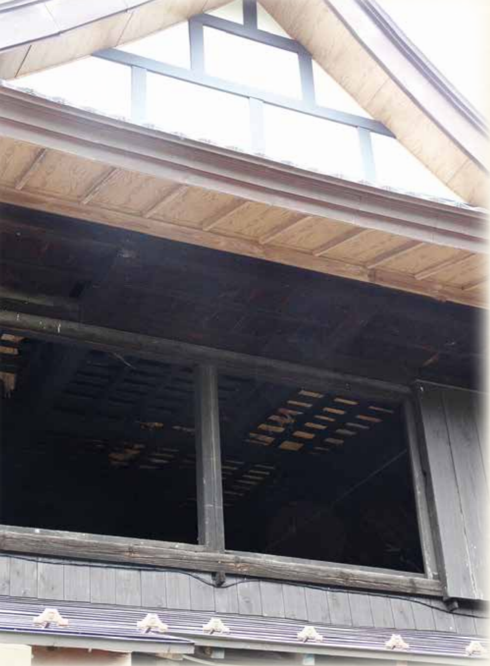
養蚕をしていた家のつくり（民宿・光荘）。通気性をよくするために3階の床がざら板（すのこ）状になっている
