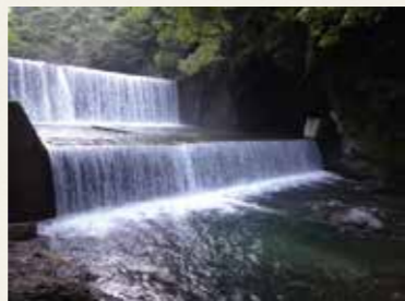
笹久根の堰堤
